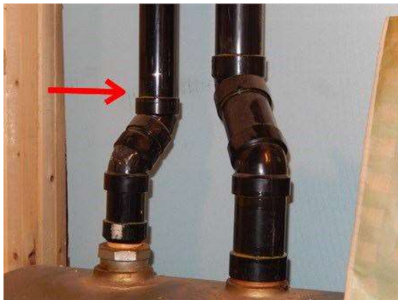
Tuyaux de remplissage.
