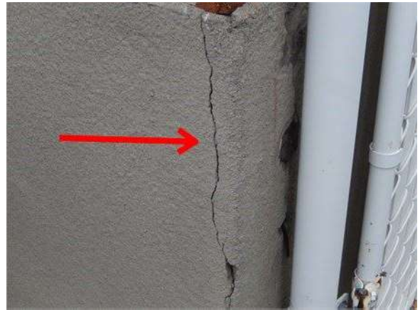
Fissure dans le coin arrière gauche.
