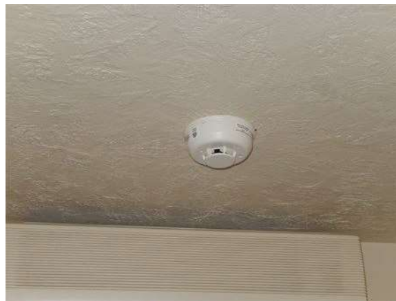
Stucco au plafond dans le passage.
