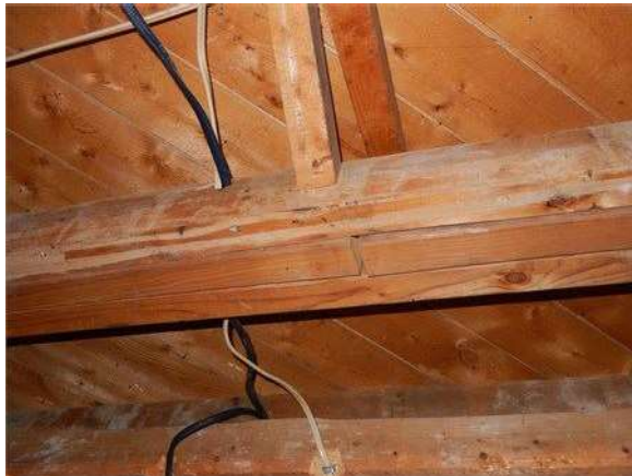
Une réparation a été effectuée à cet endroit et la solive qui avait été coupée a été renforcée par une planche de chaque côté de celle-ci.
