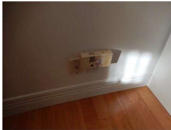
Détecteur de monoxyde de carbone dans le salon.
